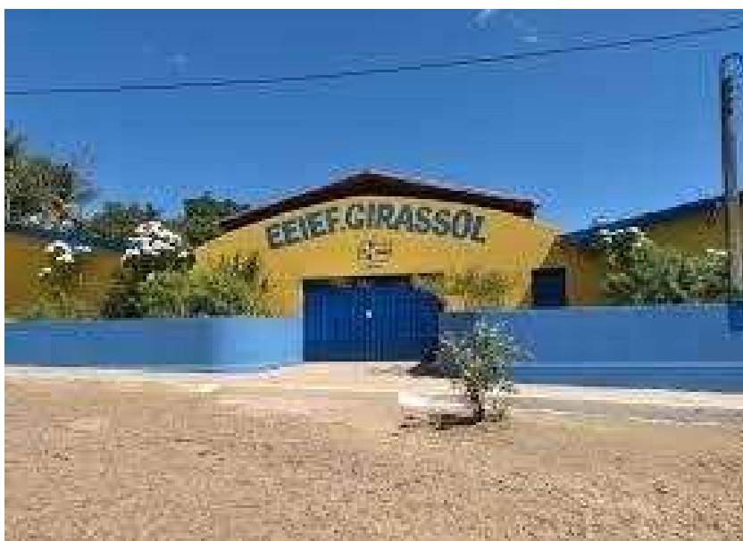
Figura 1 – Fachada da escola Girassol
