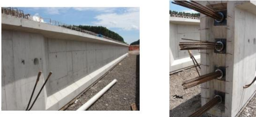
Figura 11 – Viga protendida pós-tensionada
