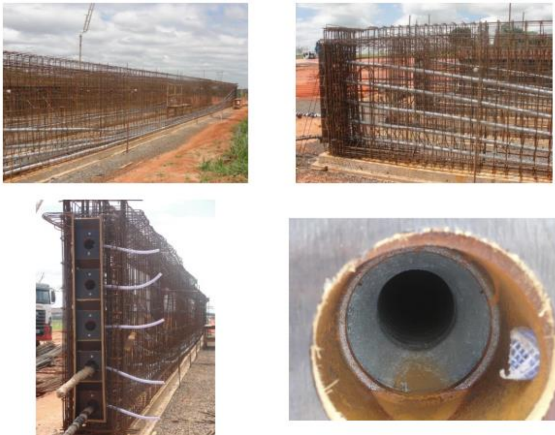
Figura 10 – Montagem das armaduras passivas e bainhas metálicas para passagem dos cabos
