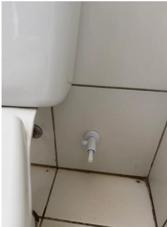
Figura 33 – Ducha quebrada Bloco K - Térreo - Banheiro masculino
