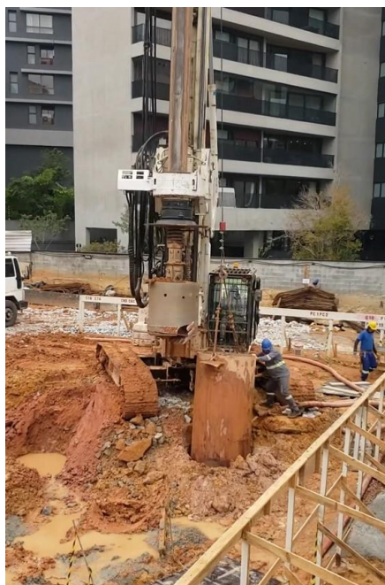
Figura 2.1 – Foto de instalação de camisa metálica em furo de estaca
