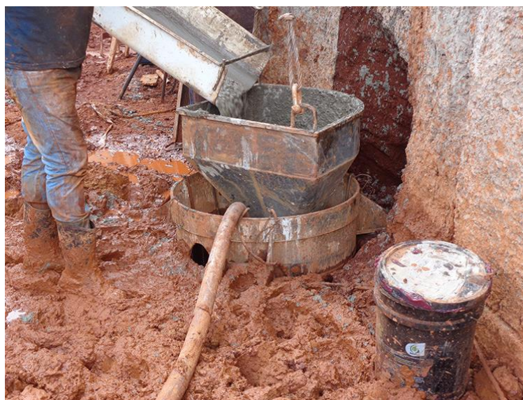
Figura 2.2 – Exemplo de estação escavado com lama bentonítica
