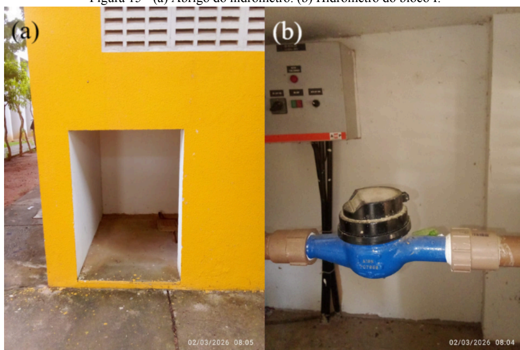
Figura 15 - (a) Abrigo do hidrômetro. (b) Hidrômetro do bloco I.
