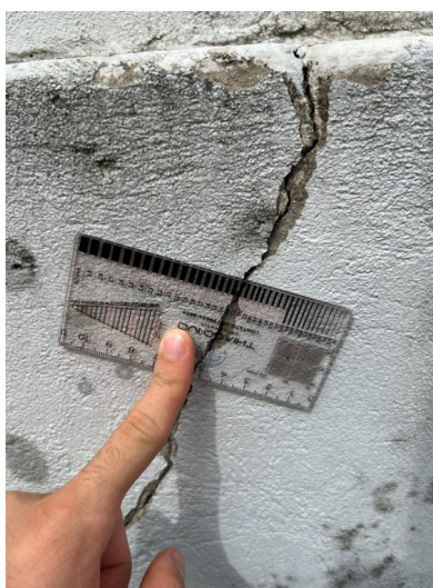
Figura 18 – Medindo Fissuras com fissurômetro
