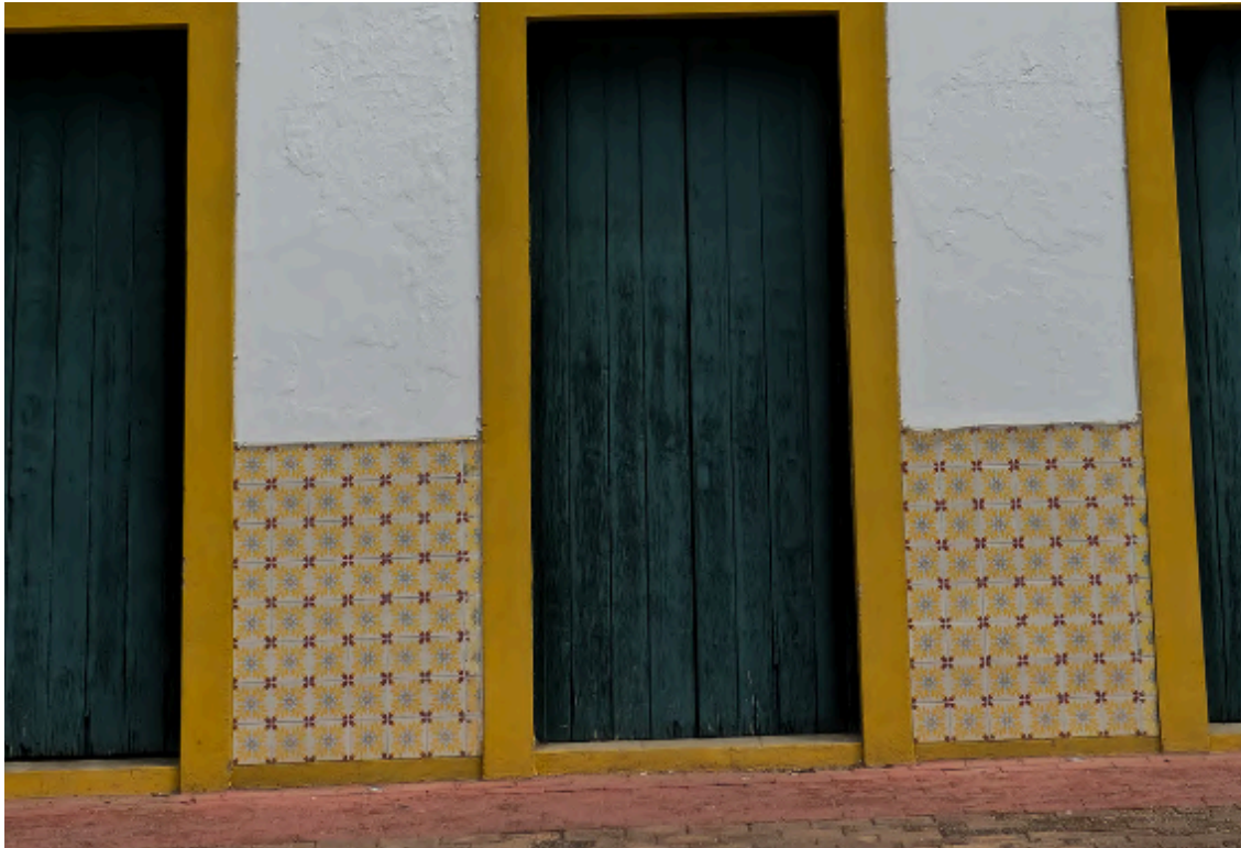
Imagem 44 - Aproximação nos azulejos da fachada do prédio
