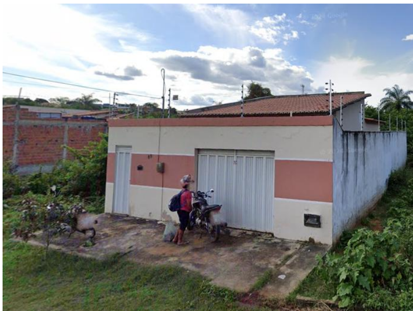
Figura 8 - Fachada da edificação
