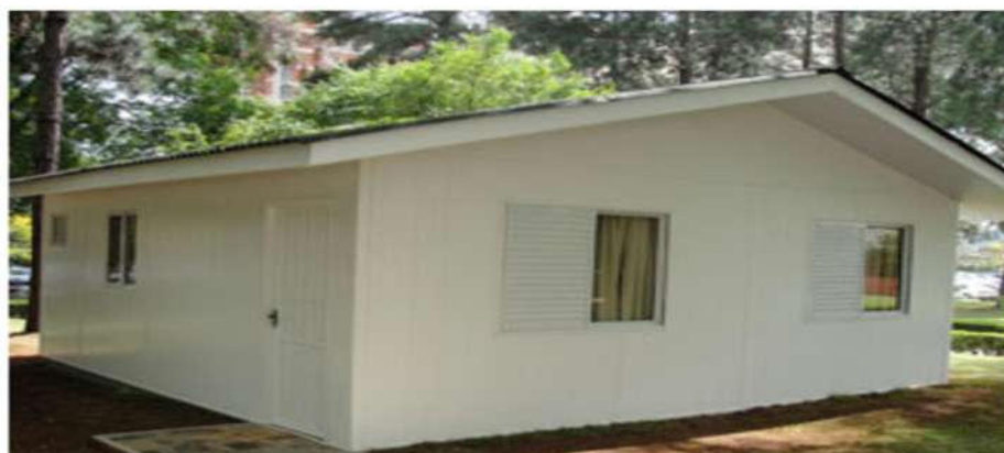
Figura 1 - Exemplo de casa popular construída com painéis de PVC
